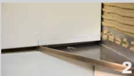
2. Fliese anzeichnen und ausklinken
